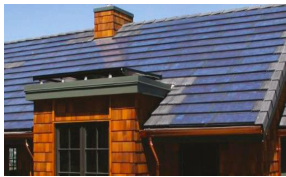
Figura 4 : Integração de PV no telhado. Fonte: https://doi.org/10.1016/j.egypro.2012.03.009 .
