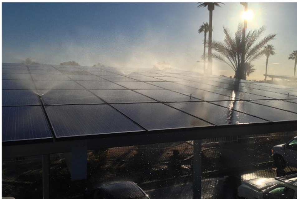
Figura 3: Método de limpeza automática com borrifadores de água da Heliotex. Fonte: https://www.solarpowerworldonline.com/2015/02/fighting-dirty-manual-washing-vs-automatic-cleaning-of-solar-modules/
