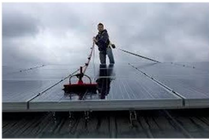
Figura 2: Limpeza manual utilizando um aparelho com sucção a vácuo. Fonte: https://www.researchgate.net/publication/314254127_A_Comparative_Study_of_Dust_Cleaning_Methods_for_the_Solar_PV_Panels
