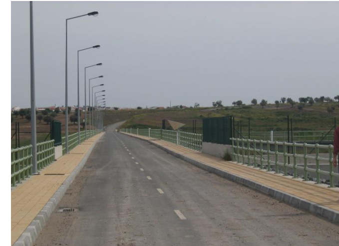
Barragem do Pizão
