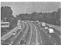
Nível de Serviço D
