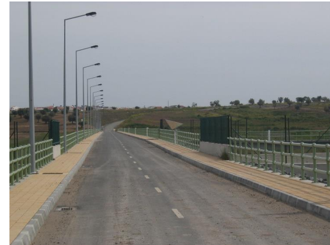
Barragem do Pizão
