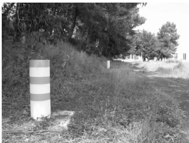
Figura 2 – Primeiros pilares da base de teste
