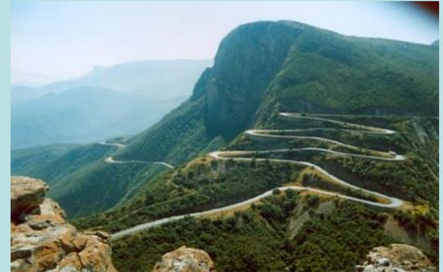
Em terrenos planos, o traçado de uma via de comunicação não é afectado pelas pendentes do terreno; se o projecto se realiza em terrenos ondulados, existe uma adaptação das pendentes do traçado às pendentes do terreno; em terrenos montanhosos, as pendentes do terreno governam o traçado.
