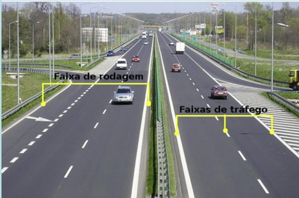
A faixa de rodagem ou pista é a parte da via pública especialmente destinada ao trânsito de veículos. É importante não confundir a faixa de rodagem com a faixa de tráfego. A faixa de rodagem corresponde ao todo da via (a pista em si). As faixas de tráfego são as subdivisões da faixa de rodagem.
