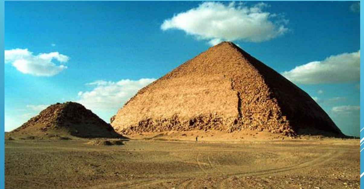
Os arqueólogos têm sugerido que durante a construção, ao ser alcançada metade da altura prevista para o caso de uma pirâmide regular (todas as 8 arestas com igual comprimento), o ângulo de inclinação da pirâmide tenha sido reduzido pelo arquitecto para tentar diminuir o volume imenso de esforço sobre as paredes das câmaras internas que, acredita-se, poderiam estar a apresentar rachaduras.
