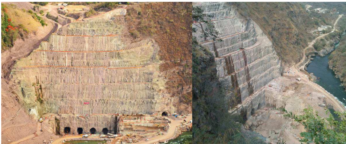
Figura 12 – Taludes de escavação da central
