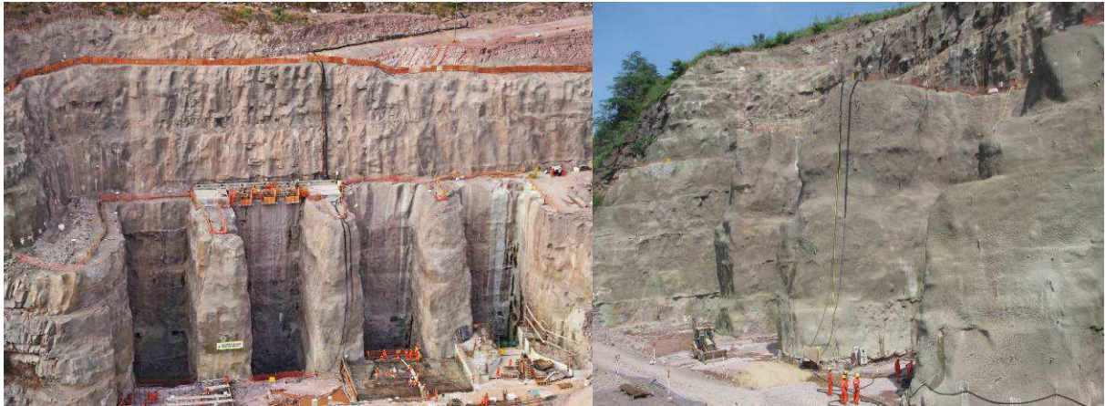
Figura 9 – Taludes de escavação da tomada de água
