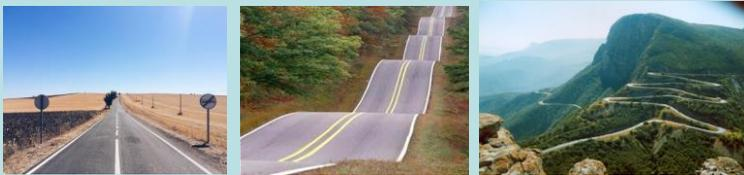
Em terrenos planos, o traçado de uma via de comunicação não é afectado pelas pendentes do terreno; se o projecto se realiza em terrenos ondulados, existe uma adaptação das pendentes do traçado às pendentes do terreno; em terrenos montanhosos, as pendentes do terreno governam o traçado.
