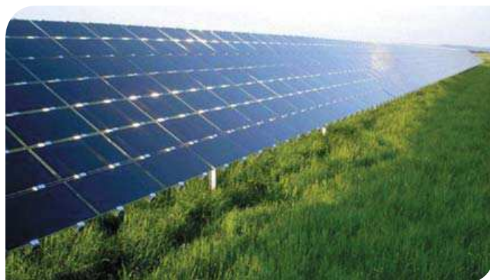
Figura 3 Instalação fotovoltaica de filme fino de CdTe (via Wiki Commons, NREL [Public domain]).
