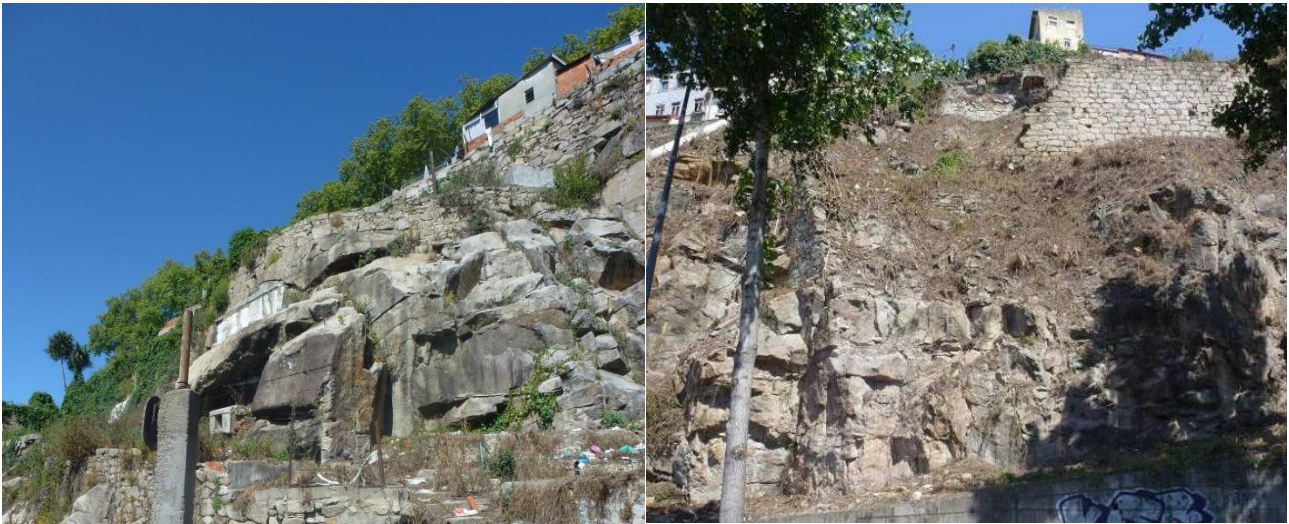
Figura 6 - Setor 3. Estado da escarpa e muros existentes antes das obras de estabilização
