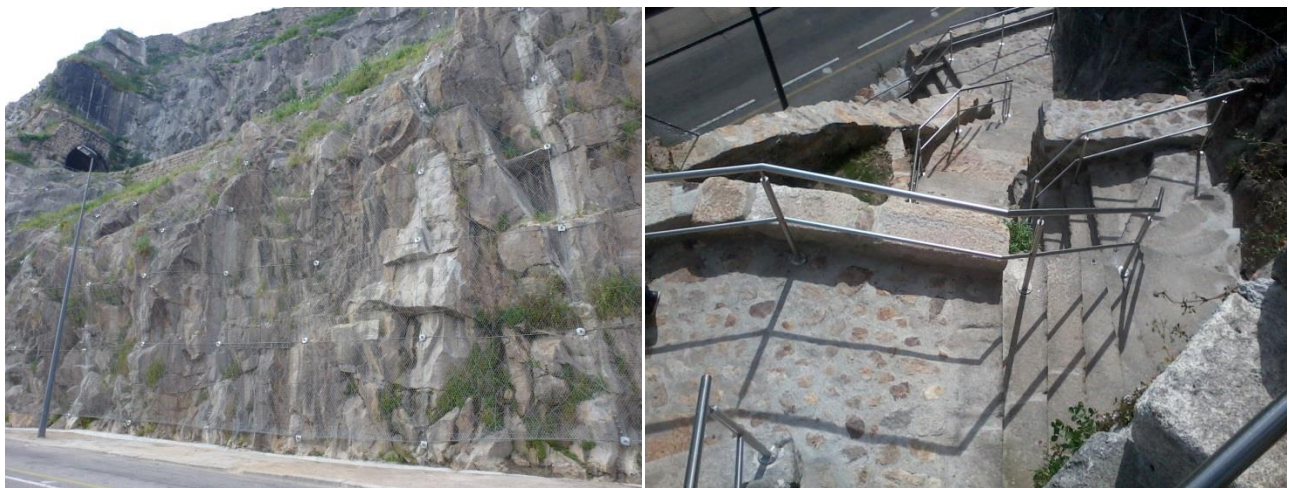
Figura 12 - Secção 5.2 após as obras de estabilização
