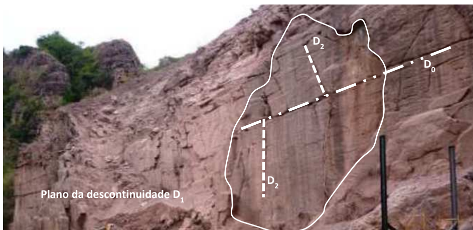
Figura 2 - Famílias de descontinuidades do maciço de escavação do emboquilhamento do túnel de acesso
