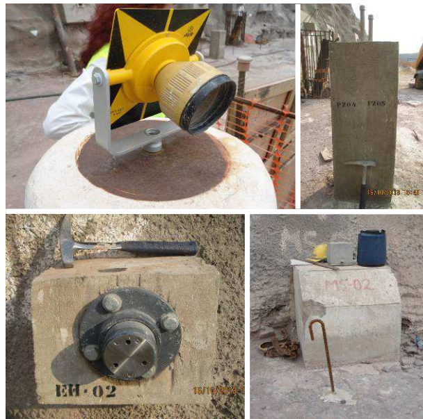
Figura 18 – Dispositivos de instrumentação e observação colocados: marco de referência, piezômetro, extensômetro de varas e marca topográfica
