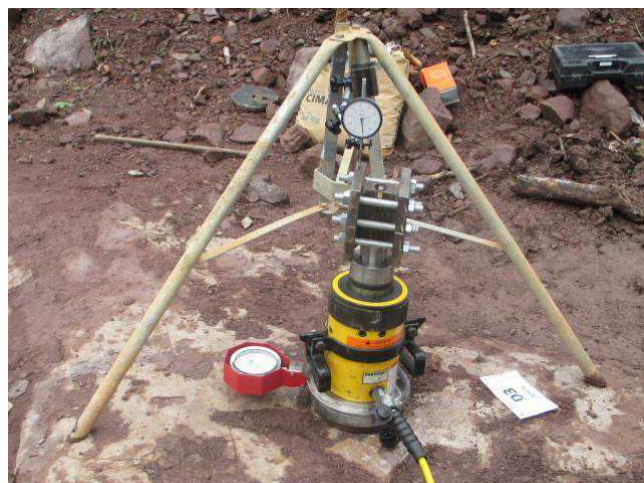
Figura 14 – Ensaio de arrancamento de pregagens
