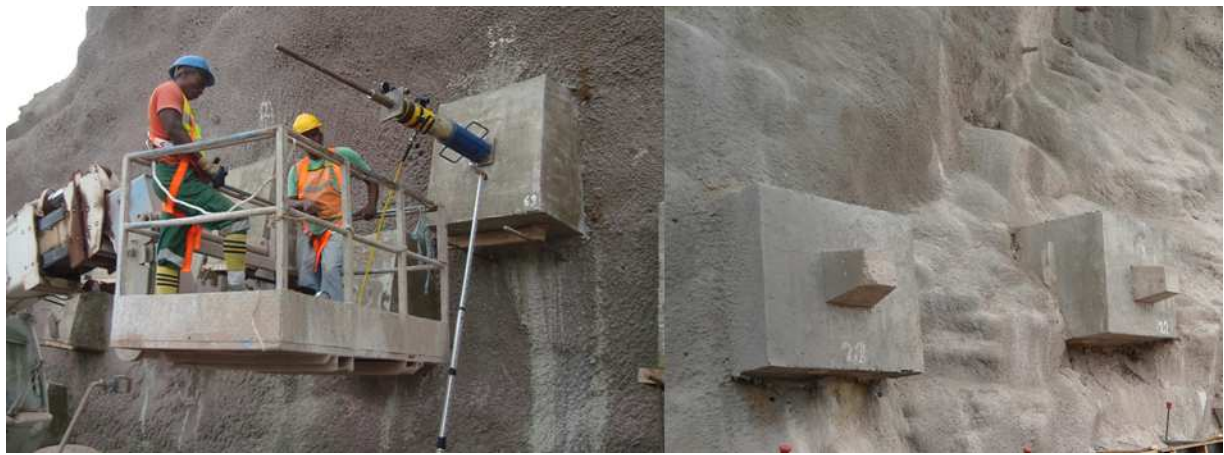
Figura 13 – Ancoragens definitivas do talude da central
