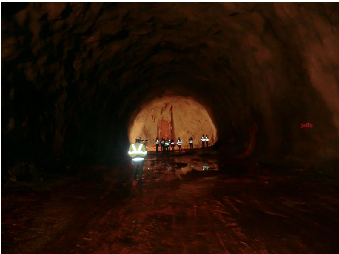
Figura 5 – Frente de escavação da galeria sul poente
