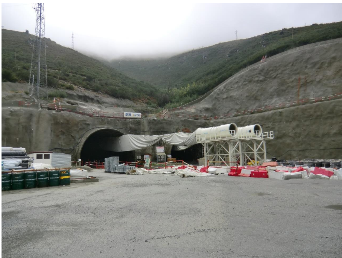
Figura 3 – Vista do Emboquilhamento Poente após suspensão dos trabalhos
