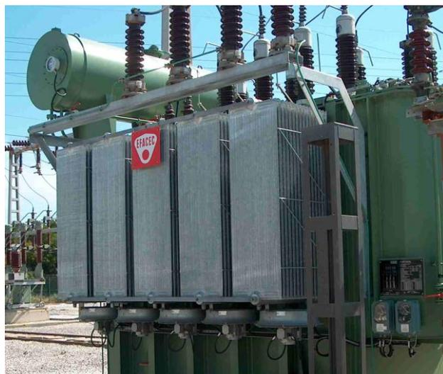
Figura 7.22. Arrefecimento tipo ONAF. Notem-se os ventiladores debaixo dos radiadores.
